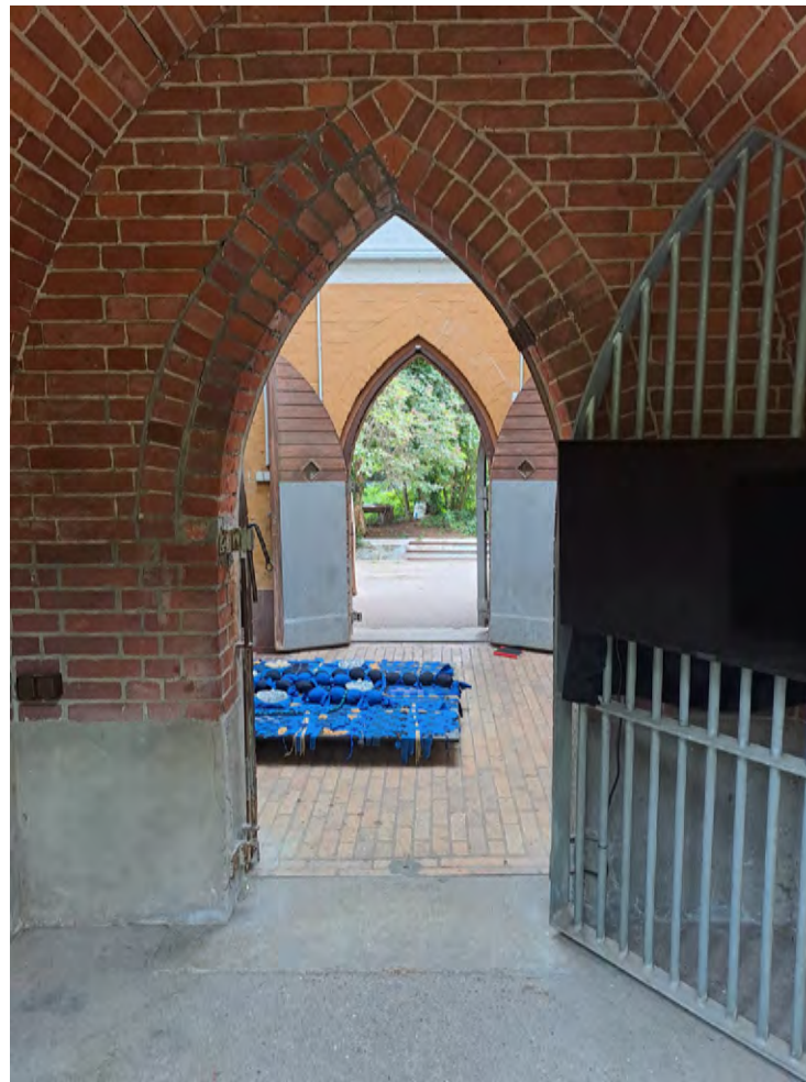
Blick von außen nach innen
